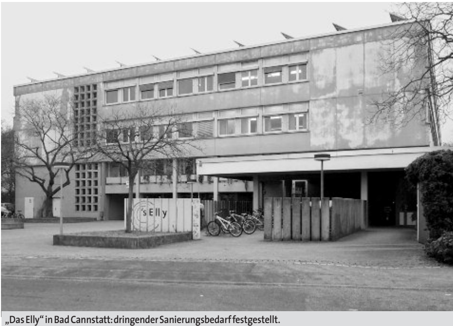
„Das Elly“ in Bad Cannstatt: dringender Sanierungsbedarf festgestellt.
