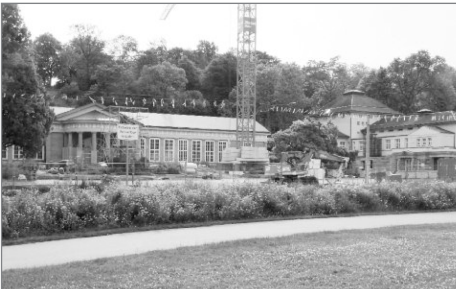
Der Kursaal - heute Baustelle, morgen hoffentlich Bürgerhaus für alle Cannstatter.
