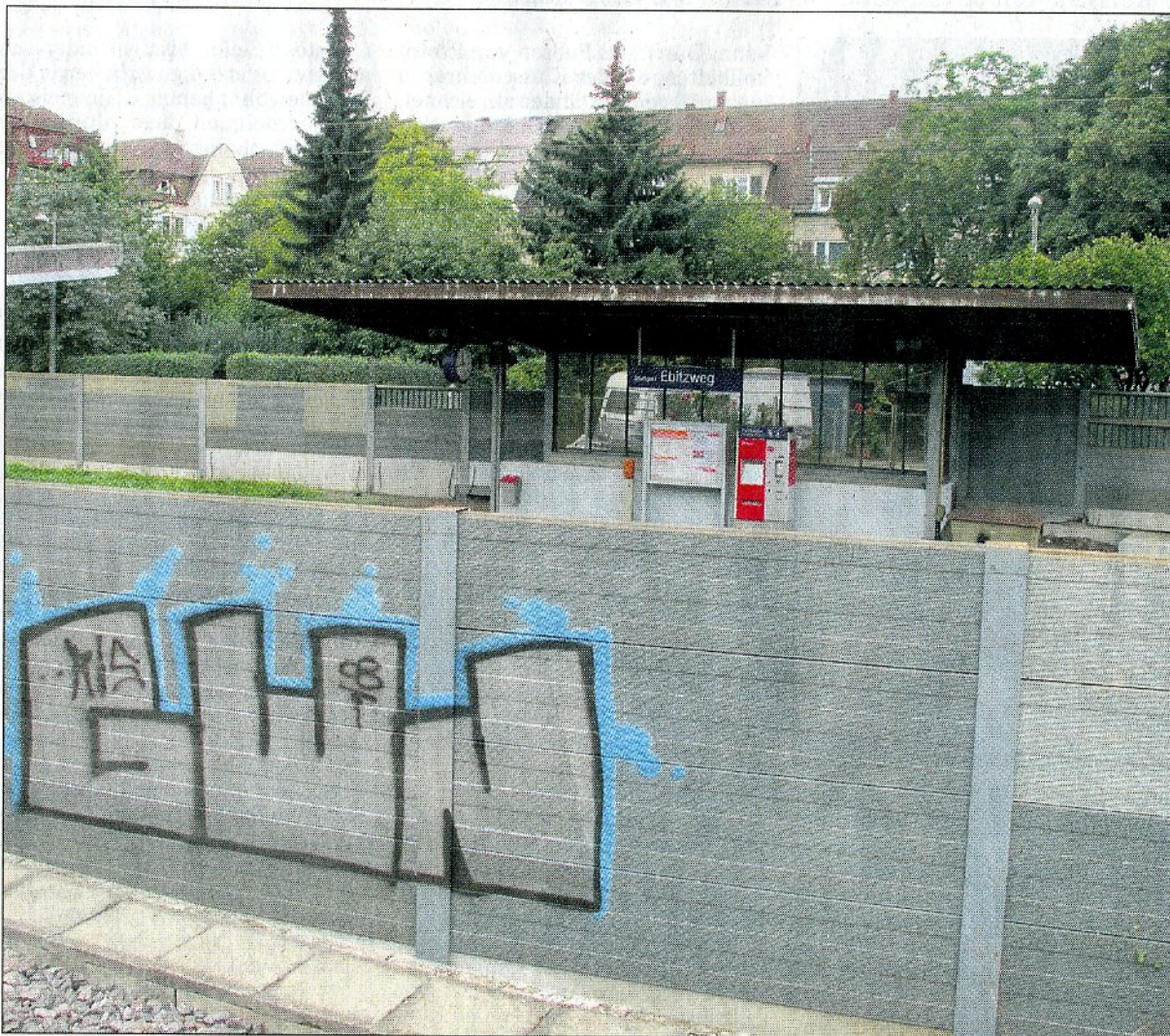
Im Bereich Ebitzweg gibt es zwar auch neu gebaute Lärmschutzwände, dennoch: Der nächtliche Güterverkehr nimmt auch in Bad Cannstatt zu. Die SPD fordert mehr Lärmschutzmaßnahmen.
